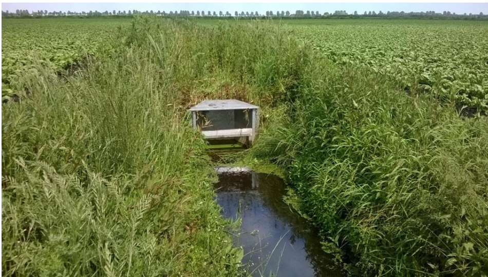
Foto links: Eén van de drie stuwttjes in de sloot. Met schotbalken kan de waterstand in de sloot worden geregeld.
